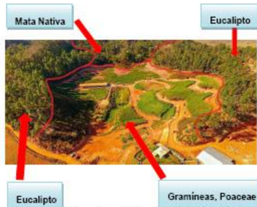
Figura 3 - Vista aérea da barragem da Unidade III.
