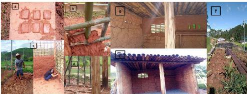
Figura 1 - a) Teste com diferentes concentrações de materiais; b) Técnica de pau-a-pique; c) Amassamento do barro; d) Uso de blocos de concretos rentes ao solo; e) Uso de garrafas de vidro para entrada de luz; f) Telhado verde e g) Estrutura ecológica.
