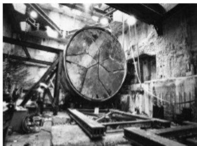
Figura 2 - Escavação do Metrô de São Paulo via TBM
