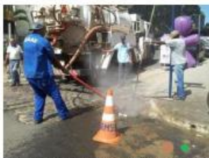
Figura 3 - Manutenção da rede de esgoto. Fonte: DEMSUR, 2018.
