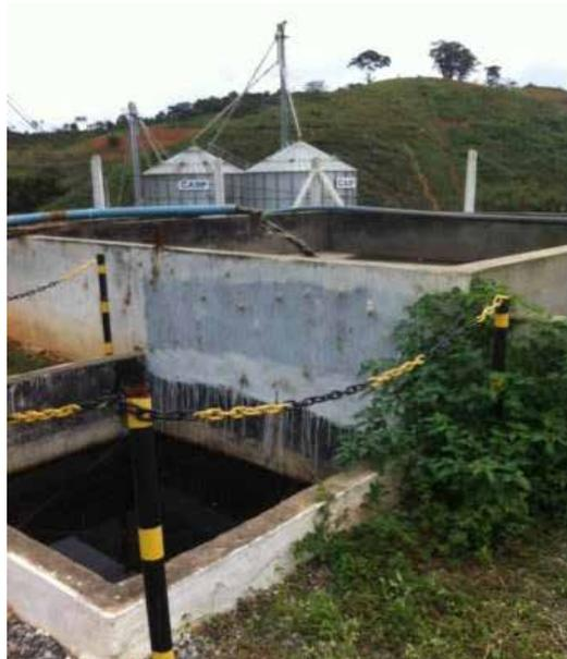
Figura 2 - Caixa de equalização, onde foi obtida amostra de efluente bruto.
