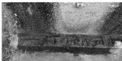
Figura 1.b – Fissuras, falta de cobertura da ferragem e bolor.
